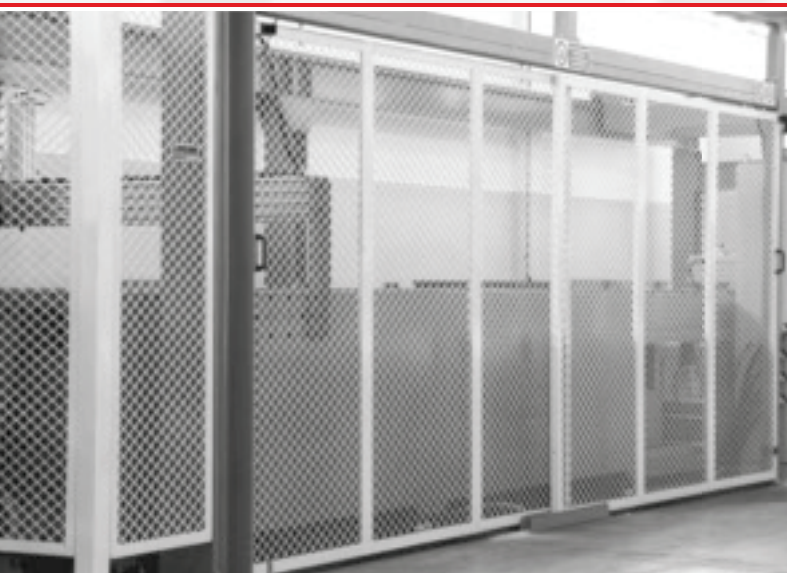
Strutture di protezione
